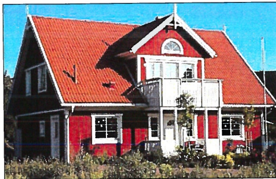
Holzfassade in klassischem Rot: So stellen sich viele das typische Schwedenhaus vor.
